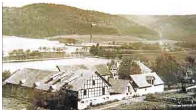
Das geschleifte Gut Kleintöpfer und die dahinter liegende Ziegelei sorgten einst für Betriebsamkeit zwischen Wendehausen und Heldra.
