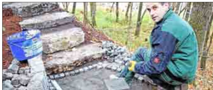
Dieter Vogtländer fasst den noch erhalten gebliebenen DDR-Grenzstein aus den 1980er-Jahren mit Granitpflaster ein. Zu ihm führt eine Natursteintreppe.
